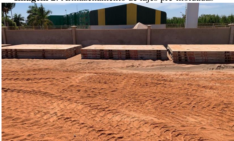
Imagem 2: Armazenamento de lajes pré-moldadas
