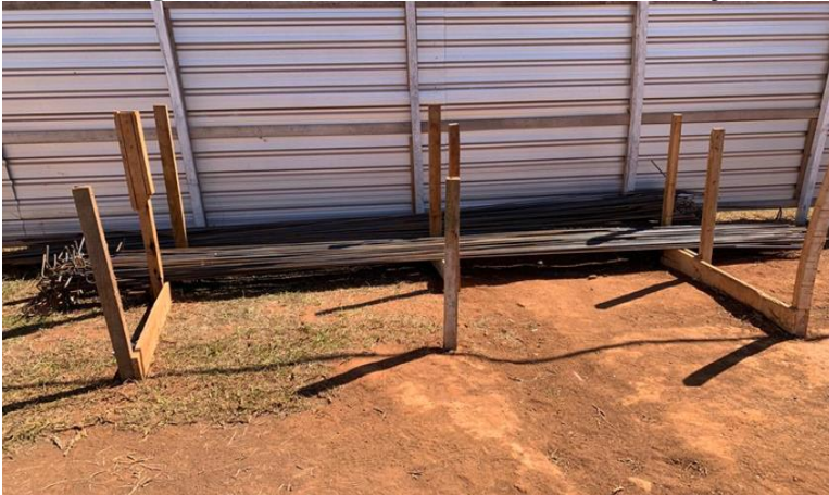
Imagem 3: - Armazenamento de barras de aço.
