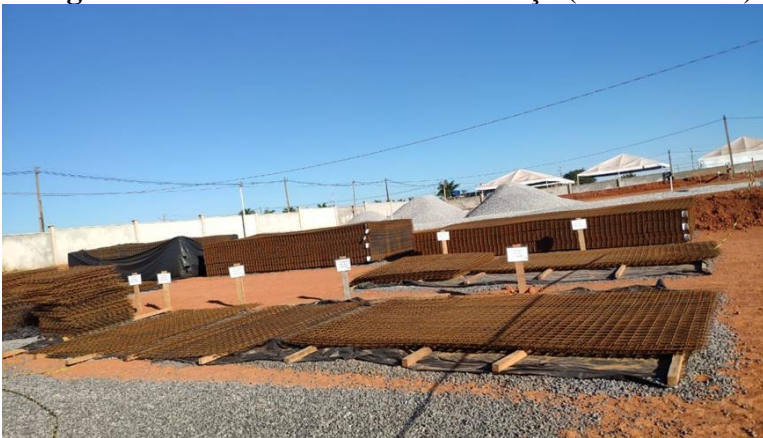
Imagem 4: Armazenamento de tela de aço (corte e dobra)
