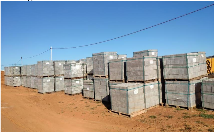
Imagem 5: Armazenamento de blocos em concreto
