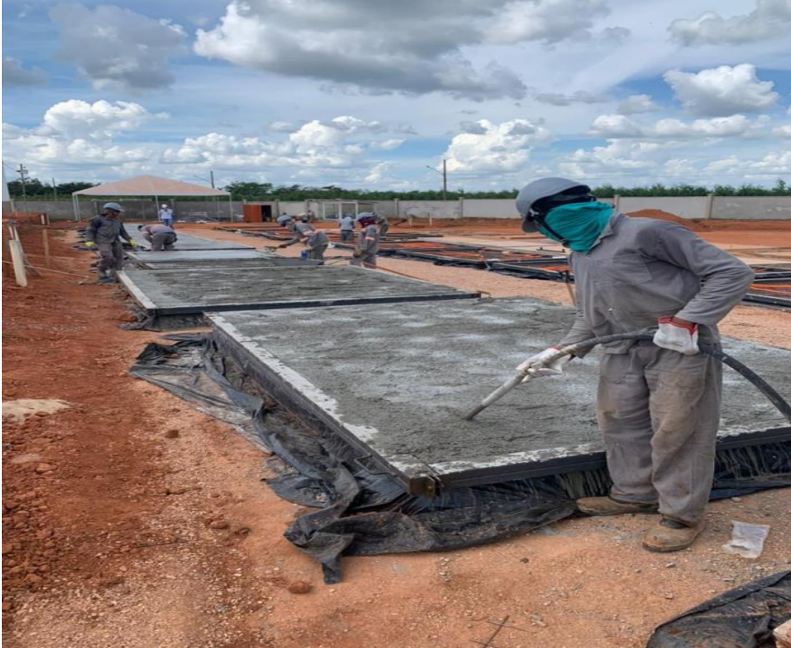
Imagem 8: Concretagem de lajes pré-moldadas
