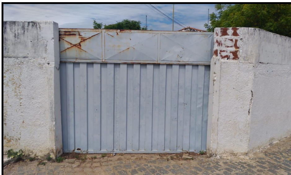
Figura 3 - Portão de acesso da edificação Fonte: Autores (2021)
