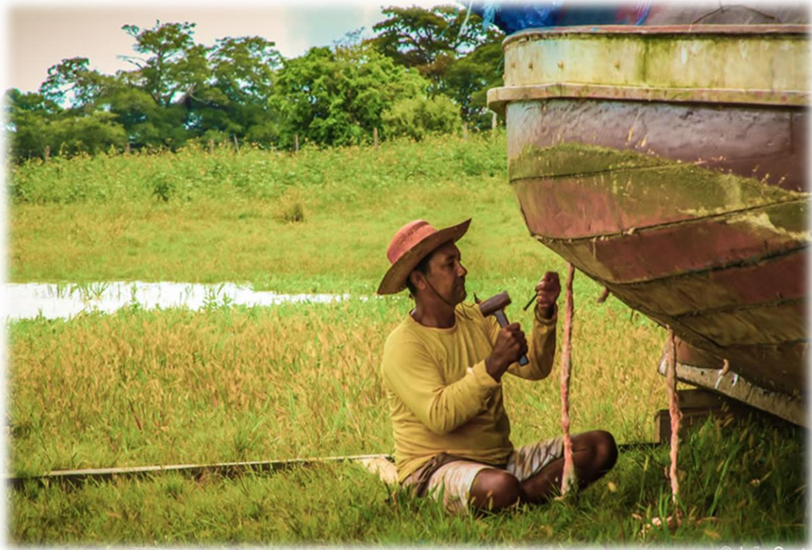
Figura 3 -Calafetagem de embarcação
