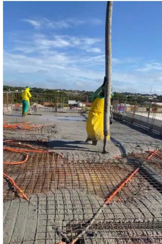
Figura 7: Concretagem das lajes Fonte: Próprio autor (2022)
