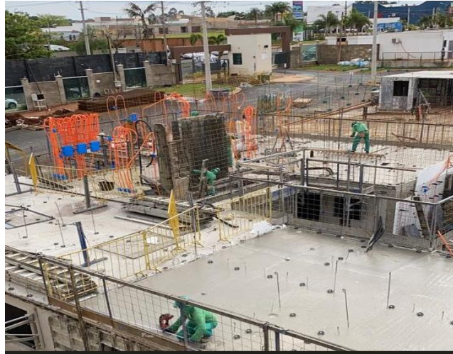
Figura 5: Montagem da fôrma Fonte: Próprio autor (2022)
