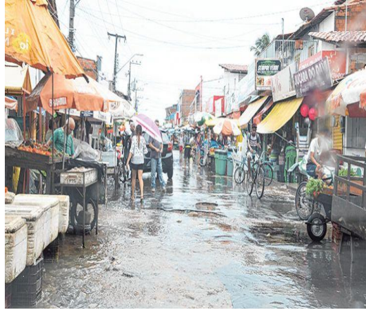
Figura 5 – Esgoto invadindo a área comercial.
