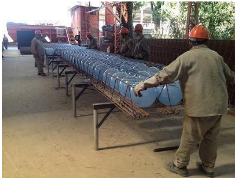
Figura 32 – Fixação das treliças na tela inferior e posicionamento das esferas
