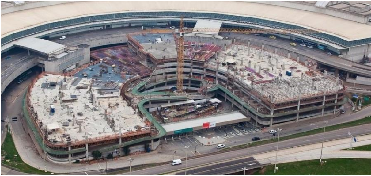
Figura 53 – Vista panorâmica Edifício Garagem –TPS 2
