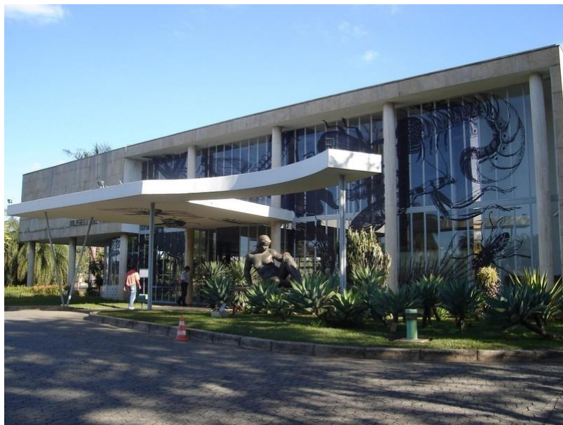
Figura 15 – Laje maciça de concreto armado Cassino da Pampulha — Belo Horizonte (1940-1942), Oscar Niemeyer
