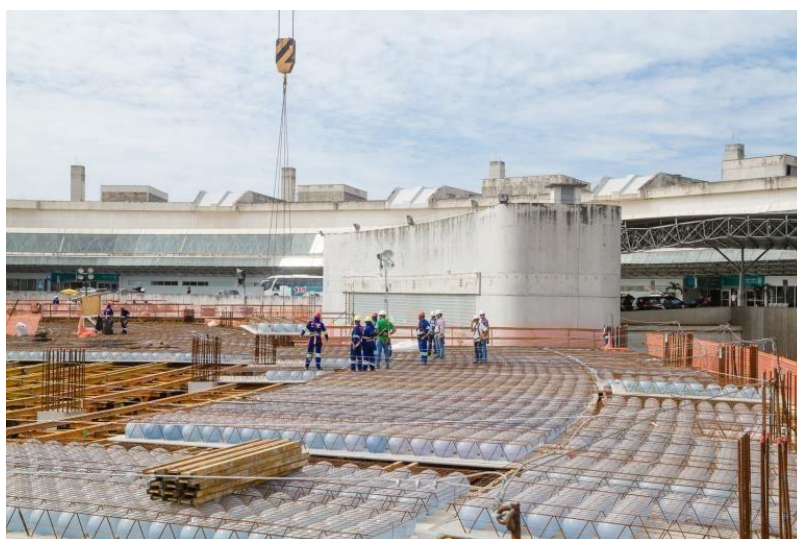
Figura 39 – Montagem do escoramento
