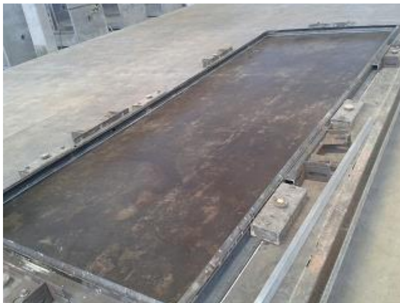
Figura 33 – Limpeza, travamento e aplicação de desmoldante nas formas
