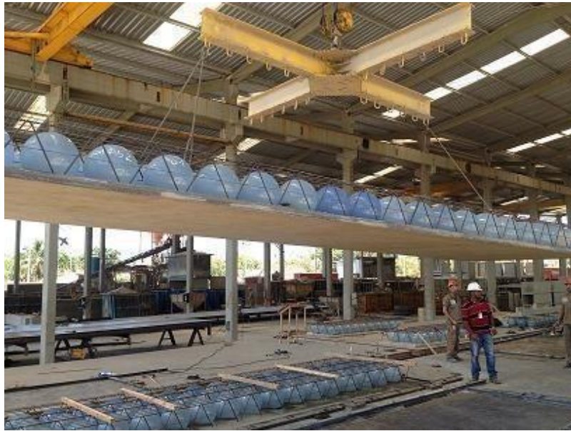
Figura 36 – Desformando painel pré-moldado
