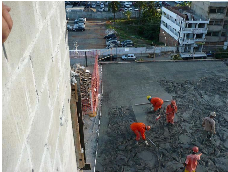
Figura 6 – Segundo estágio de concretagem
