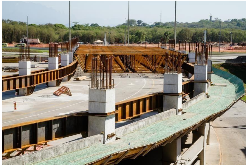
Figura 49 – Escoramento responsável pela distribuição das cargas para os sistemas de vigas e consoles (Treliças ULMA)
