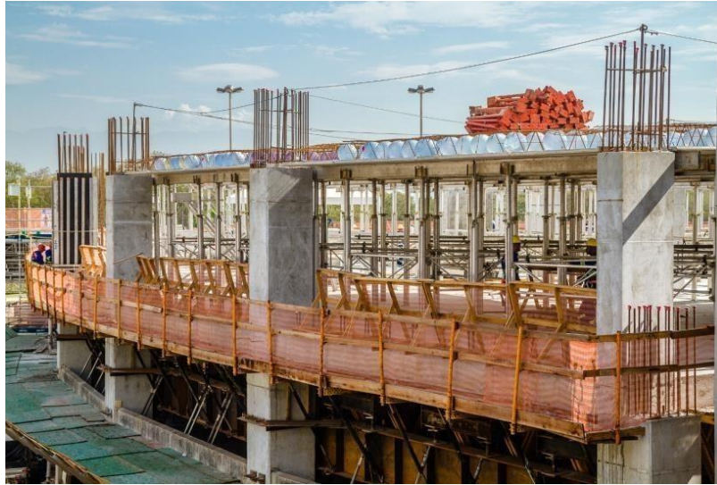
Figura 51 – Lajes BBD aplicadas sobre cimbramento MILLS (mesas)
