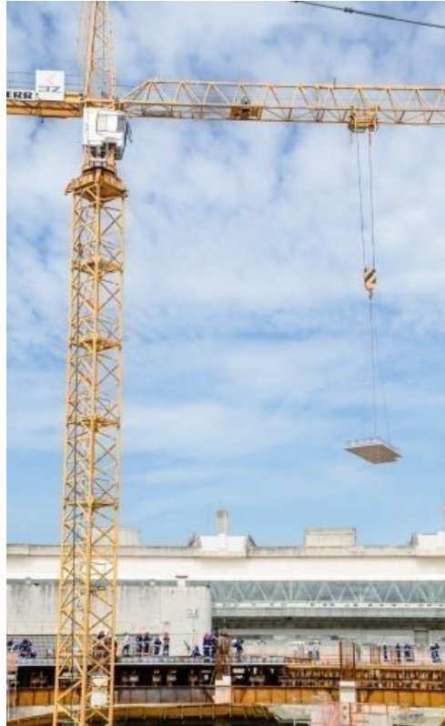
Figura 38 – Transporte e lançamento dos painéis por grua
