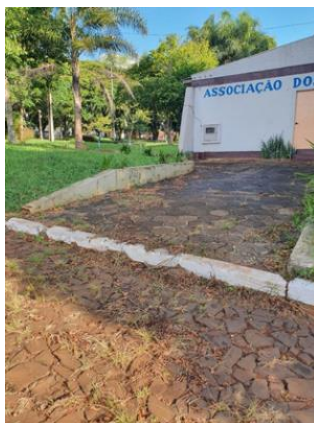
Figura 11: Acesso à Sede do Bairro
