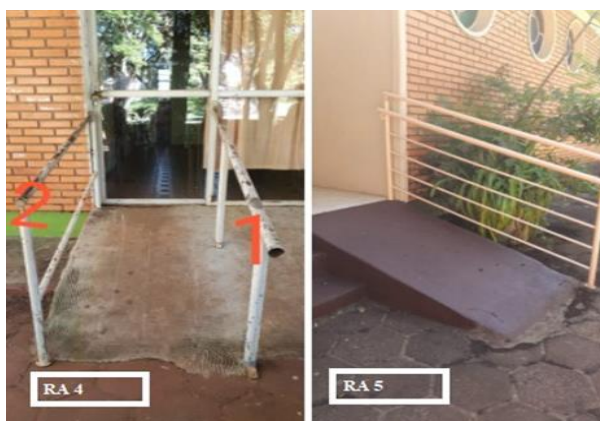
Figura 2: RAs às edificações
