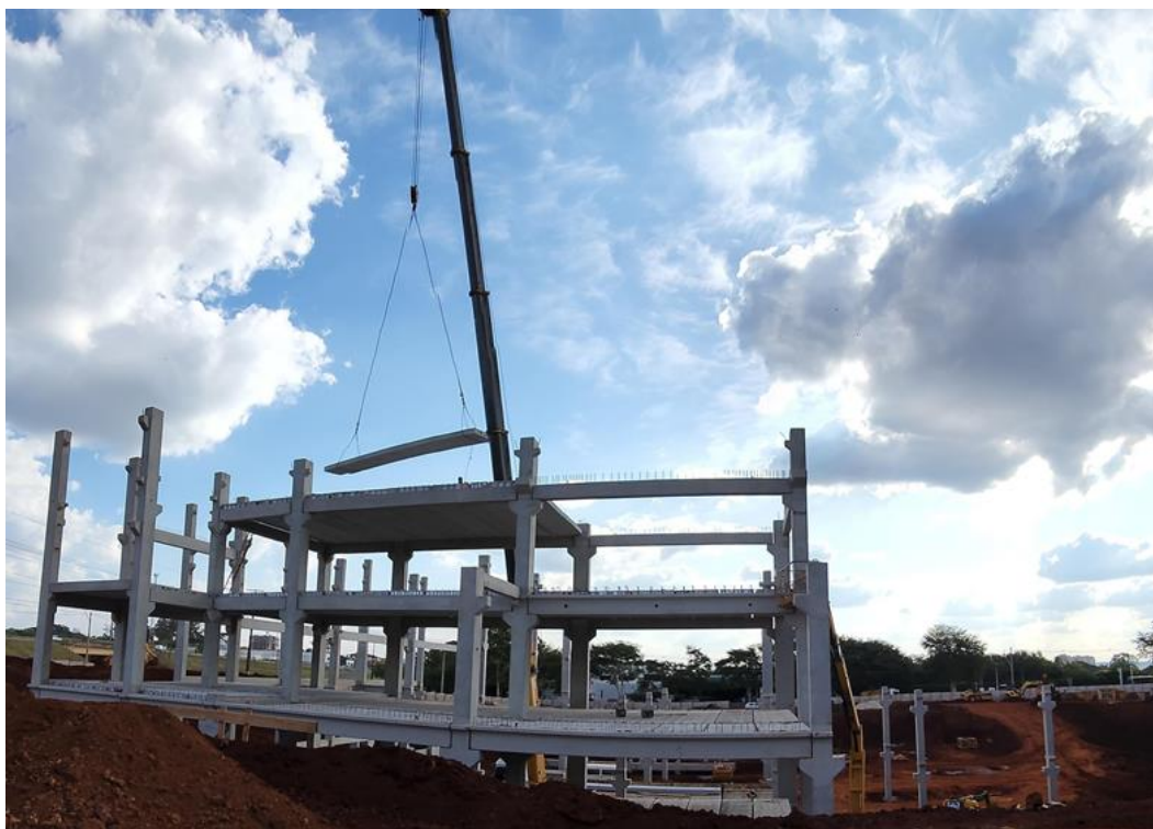
Figura 3 - Montagem dos elementos pré-fabricados Fonte: (Autoria Própria, 2023)
