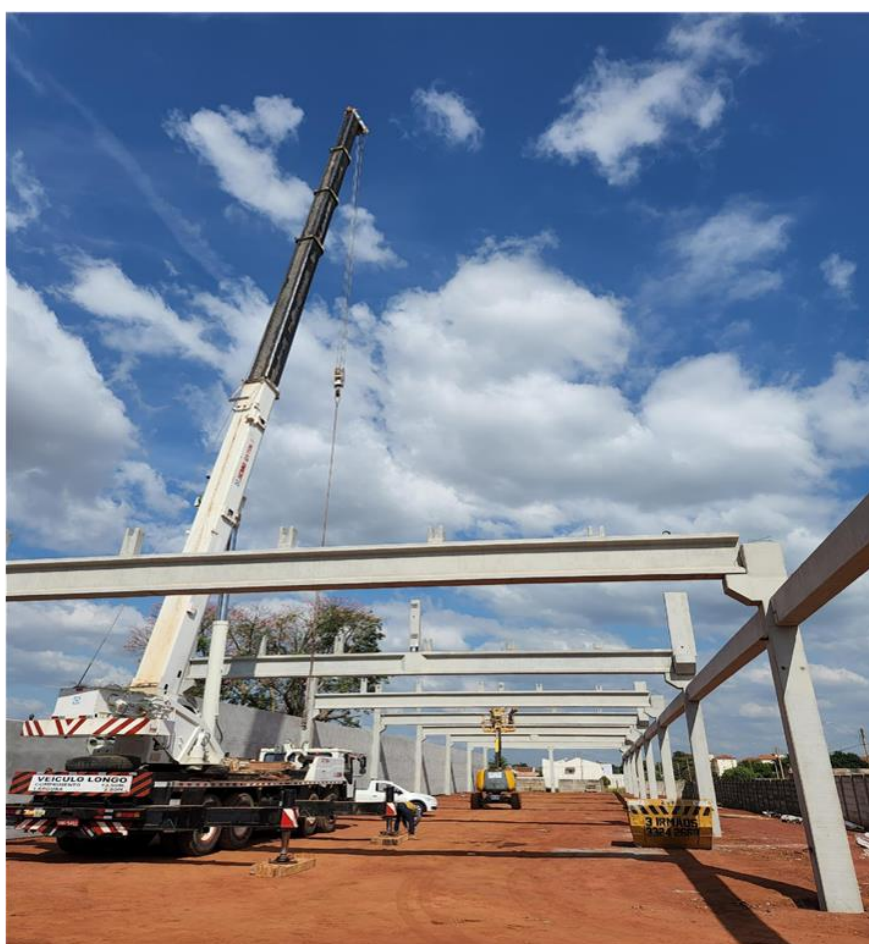
Figura 5 - Processo de montagem Fonte: (Autoria Própria, 2023)
