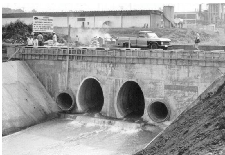
Figura 6 - Canalização dos córregos: início das obras do Servidão foi feita pelo prefeito Benedito de Oliveira em 1963. Fonte: (RCIA, 2023)
