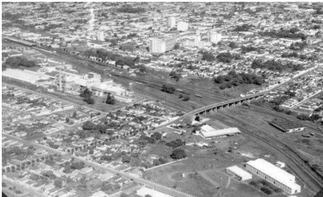
Figura 1 - Pontilhão da avenida Barroso Fonte: (ACIDADEON, 2023)
