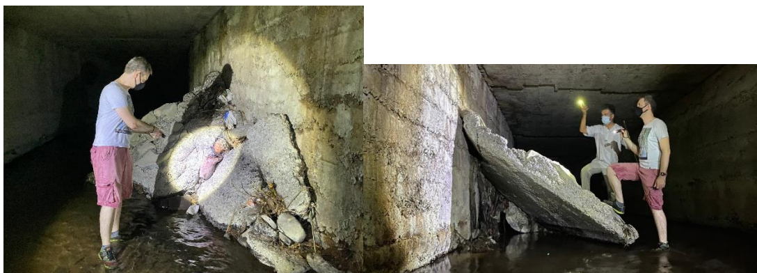
Figura 4 - Área interna da galeria. Fonte: (ARQ, 2023)
