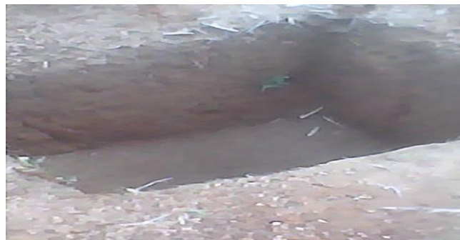
Figura 1: Fotografias tiradas no local da construção da fossa biodigestora
