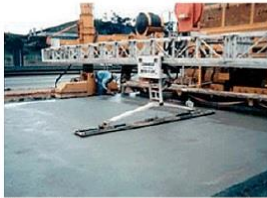
(b) Revestimento em concreto de cimento Portland sendo executado
