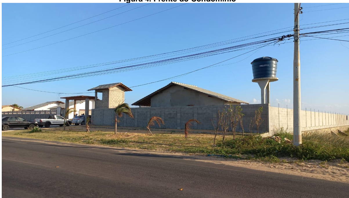
Figura 4. Frente do Condomínio
