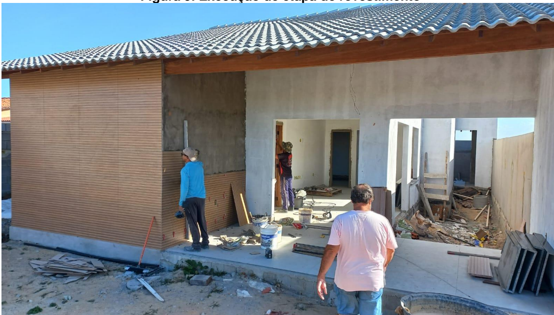
Figura 9. Execução de etapa de revestimento
