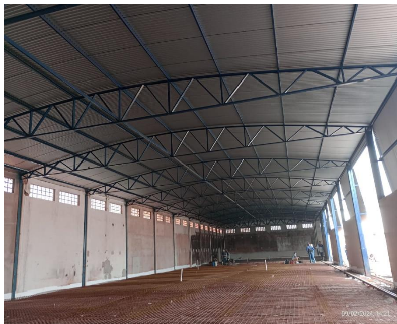
Figura 6 - Situação interna após reforma da estrutura metálica Fonte: O autor, 2024
