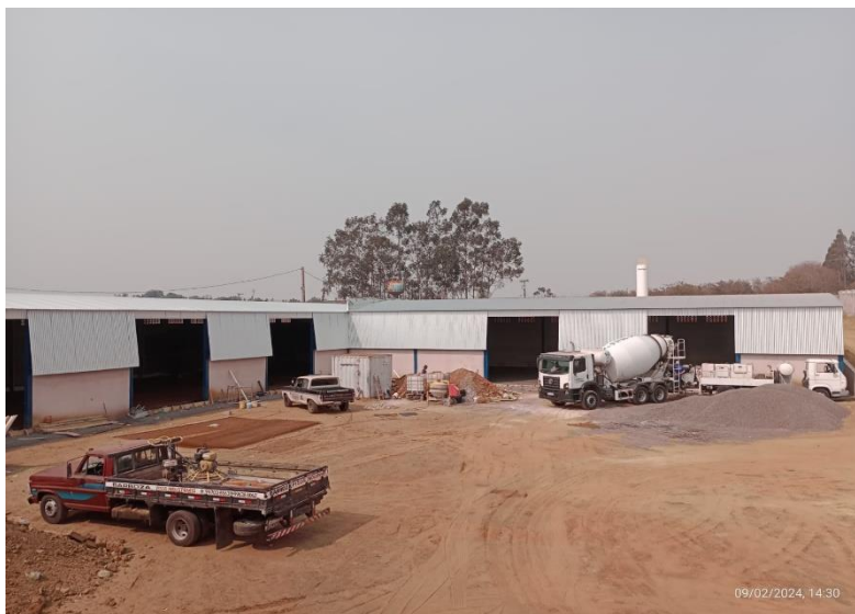
Figura 5 - Situação externa após reforma da estrutura metálica Fonte: O autor, 2024
