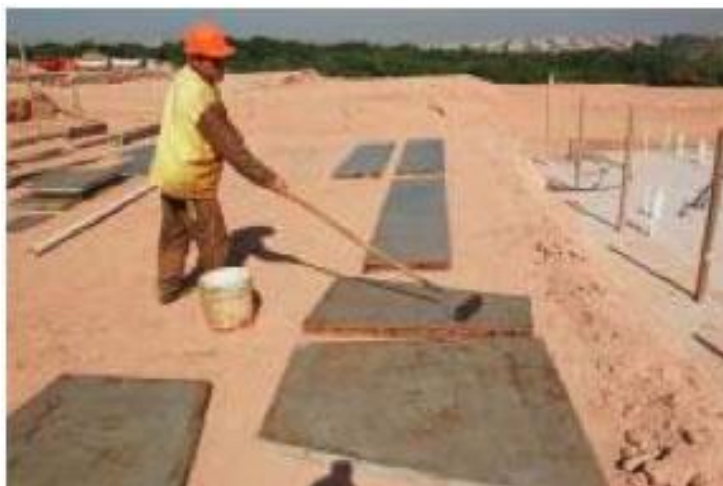
Figura 10 - Aplicação do desmoldante Fonte: (COMUNIDADE DA CONSTRUÇÃO, 2021)
