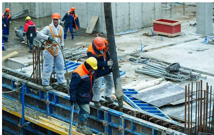
Figura 8 - Lançamento do concreto nas fôrmas Fonte: (MAPA DA OBRA, 2021)
