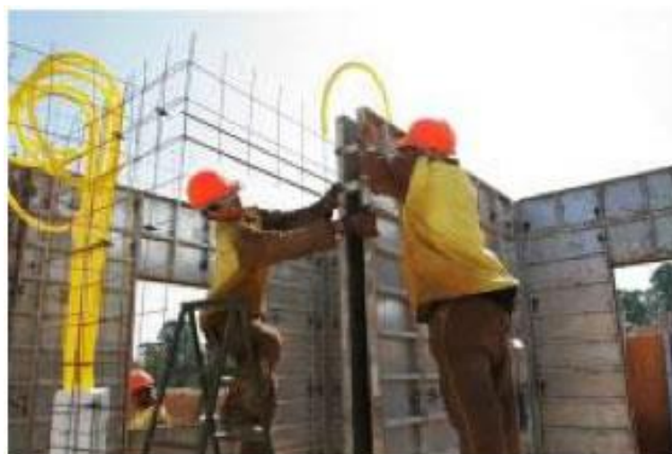
Figura 5 - Fechamento dos painéis
