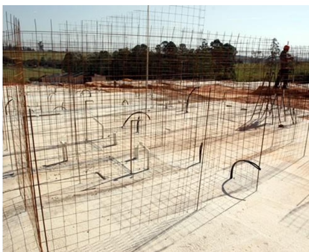
Figura 3 - Montagem das armaduras da parede de concreto Fonte:(CLUBE DO CONCRETO, 2021)
