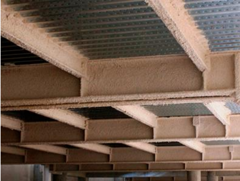
Figura 12: Argamassa Projetada Contra Fogo.
