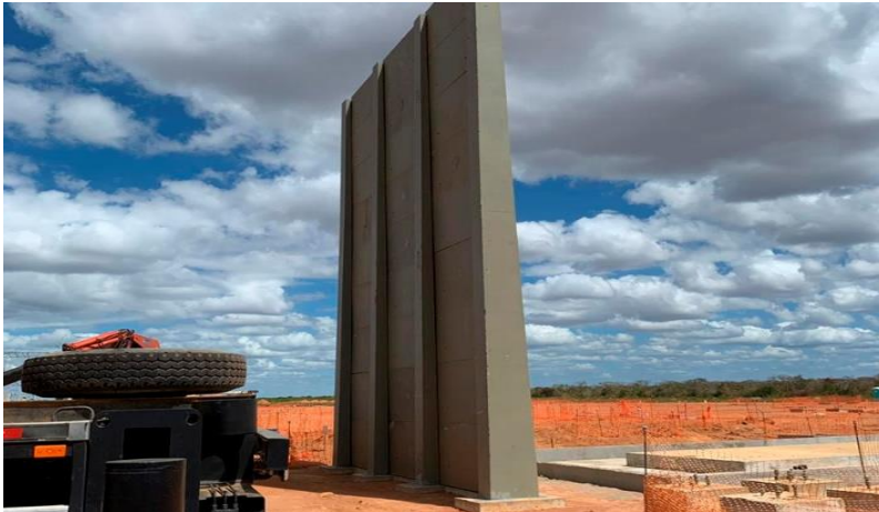
Figura 10: Parede corta fogo pré-moldada.
