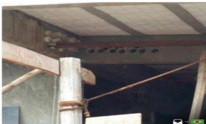
Figura 5: Incompatibilidade entre projetos hidráulico e estrutural Fonte: (MAISENGENHARIA, 2021)
