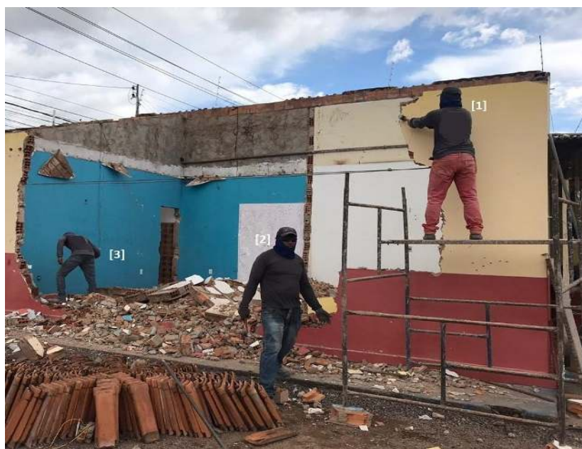
Figura 1 - Trabalho em altura 01
