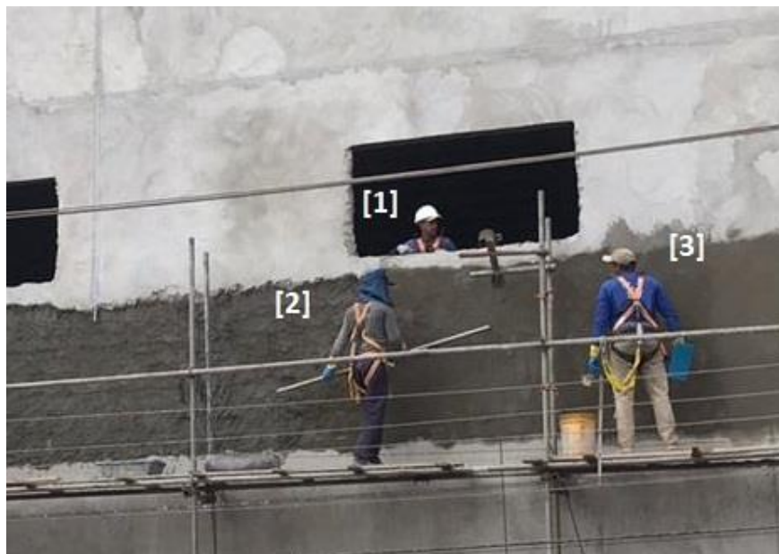
Figura 2 - Trabalho em altura 02.
