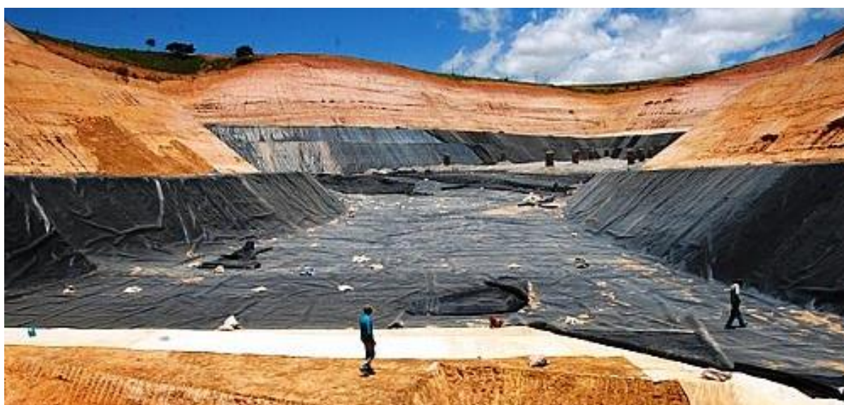
Figura 10 - Aterro Sanitário - Preparo do fundo ou base 10
