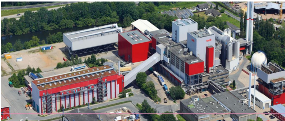
Figura 11 - Usina de Incineração de Lixo (Bremen, Alemanha 2013) 11
