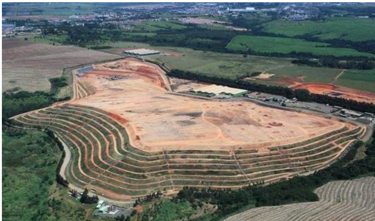
Figura 9 - Aterro Sanitário - Vista aérea 9
