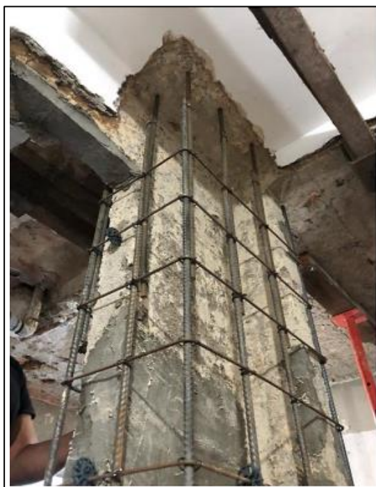
Figura 5 – Armadura do reforço por encamisamento.
