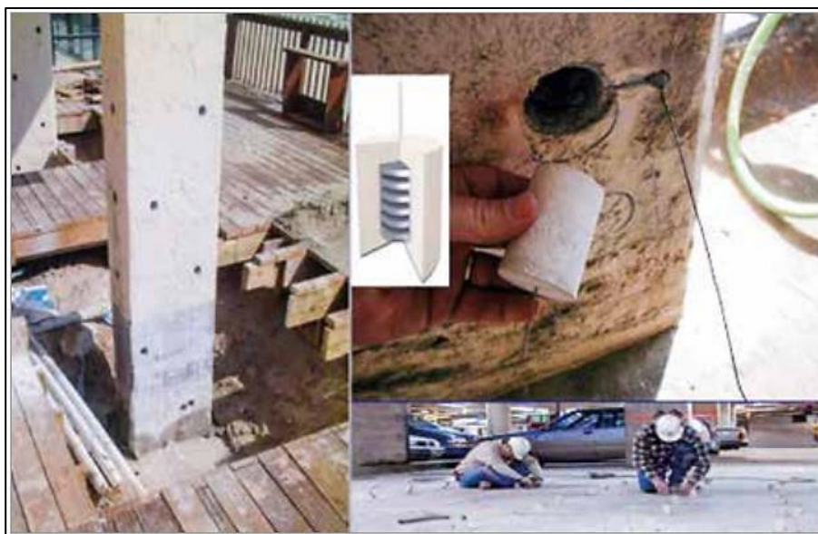
Figura 3 – Exemplos de instalação dos ânodos nos locais onde a corrosão já foi detectada pelas medições dos potenciais de corrosão, mas ainda não aflorou.
