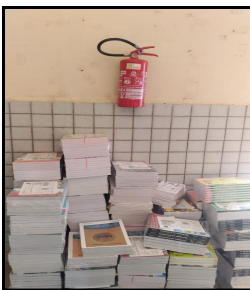
Figura 6 – Extintor sem sinalização Fonte: Autores (2021)
