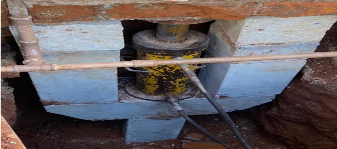
Figura 6: Macaco hidráulico devidamente encaixado para execução. Fonte: (AUTORIA PRÓPRIA)
