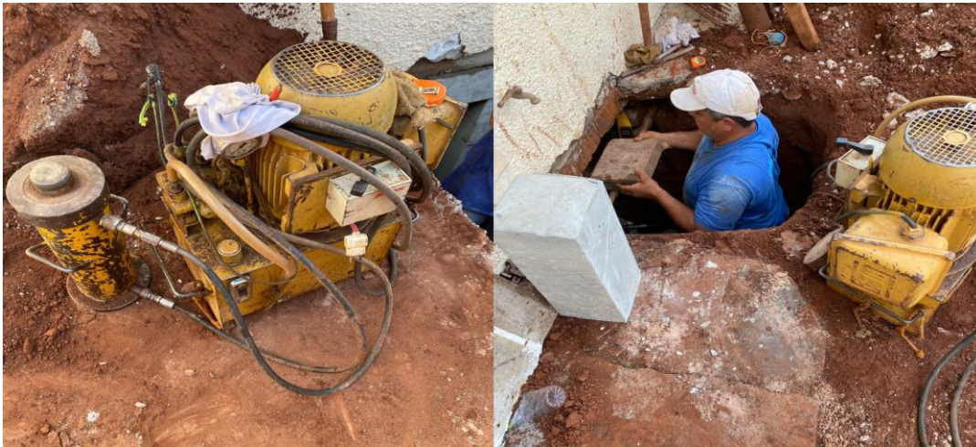
Figura 5: Macaco hidráulico e abertura para operário. Fonte: (AUTORIA PRÓPRIA)
