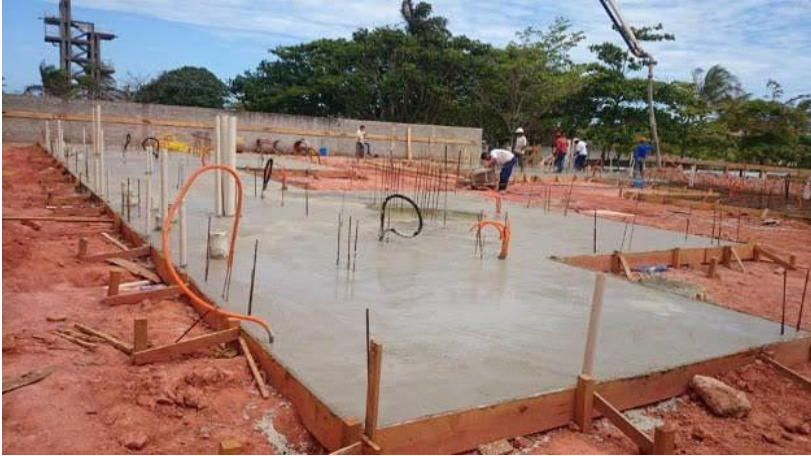
Figura 3: Radier. Fonte: (ESCOLA ENGENHARIA, 2020)
