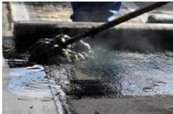
Figura 7: Aplicação da massa asfáltica com asfalto Fonte: Pinheiro (2019)
