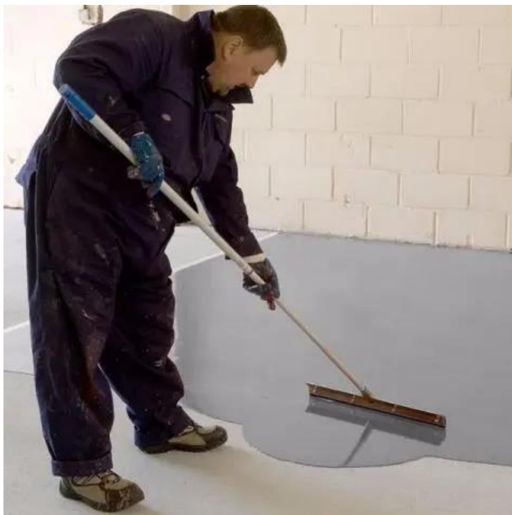
Figura 4: Aplicação de resina epóxi Fonte: Pinheiro (2019)
