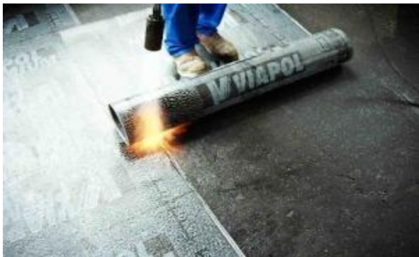
Figura 6: Aplicação da massa asfáltica aderida Fonte: Pinheiro (2019)
