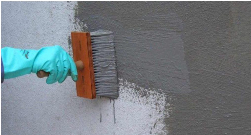
Figura 2: Aplicação da argamassa polímera Fonte: Pinheiro (2019)
