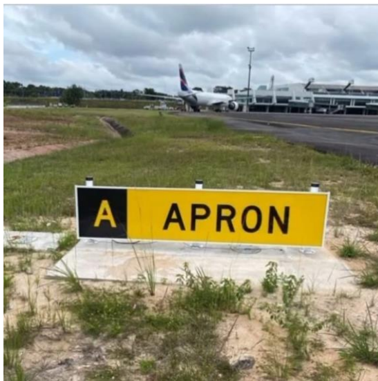
Figura 10 – Placa de sinalização com informação ao piloto de parada na pista A – Alfa Fonte: Autor
