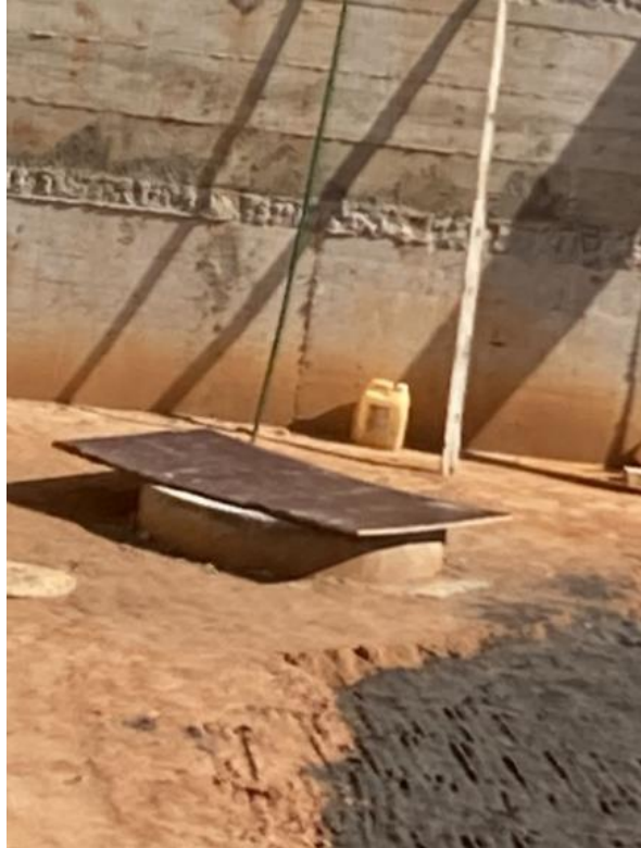
Figura 1: Poço de drenagem Fonte: autor
