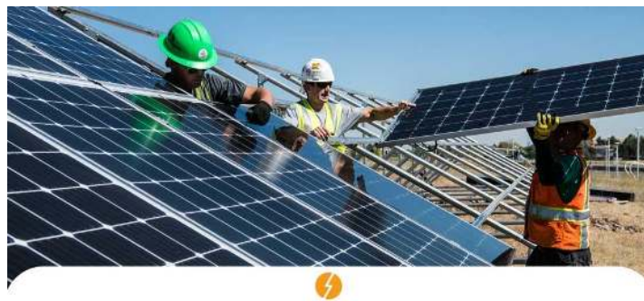
Figura 2 – Painéis solares fotovoltaicos Fonte: PORTALSOLAR
