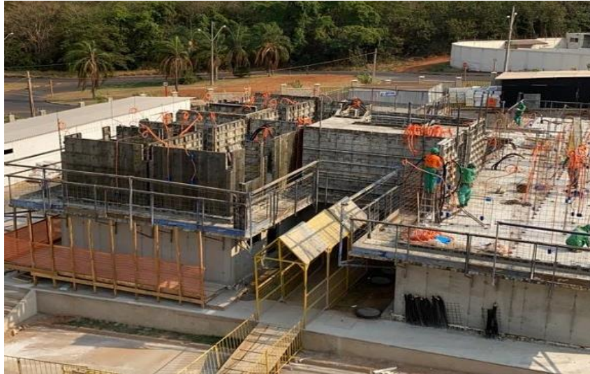
Figura 3: Formas da parede de concreto Fonte: próprio autor (2022)
