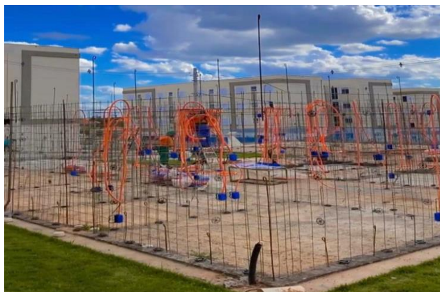
Figura 4: Armação da parede de concreto Fonte: Próprio autor (2022)
