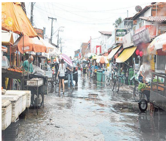
Figura 5 – Esgoto invadindo a área comercial.
