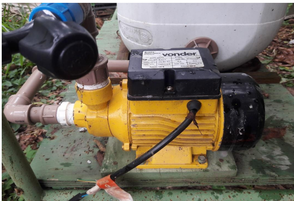
Figura 1- Bomba Periférica Monofásica.
