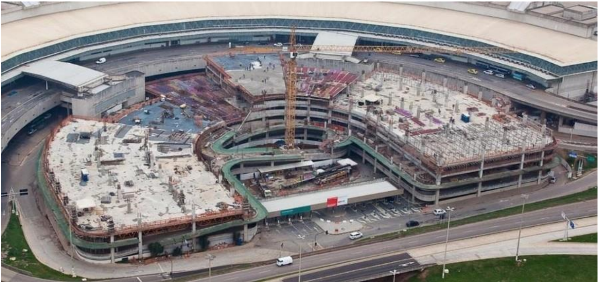
Figura 53 – Vista panorâmica Edifício Garagem –TPS 2
