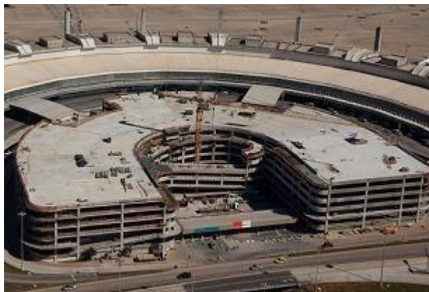
Figura 31 – Edifício Garagem (EDG) – TPS2 – Aeroporto Internacional Antônio Carlos Jobim
