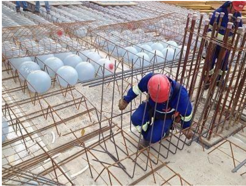
Figura 40 – Colocação da armadura complementar
