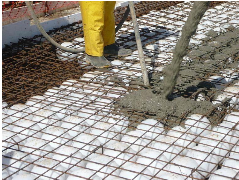
Figura 5 – Primeiro estágio de concretagem da laje Bubbledeck
