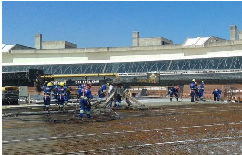
Figura 41 – Montagem das formas laterais e concretagem
