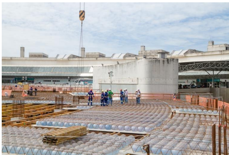
Figura 39 – Montagem do escoramento
