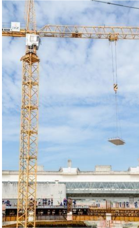
Figura 38 – Transporte e lançamento dos painéis por grua
