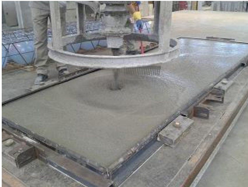
Figura 34 – Lançamento do concreto
