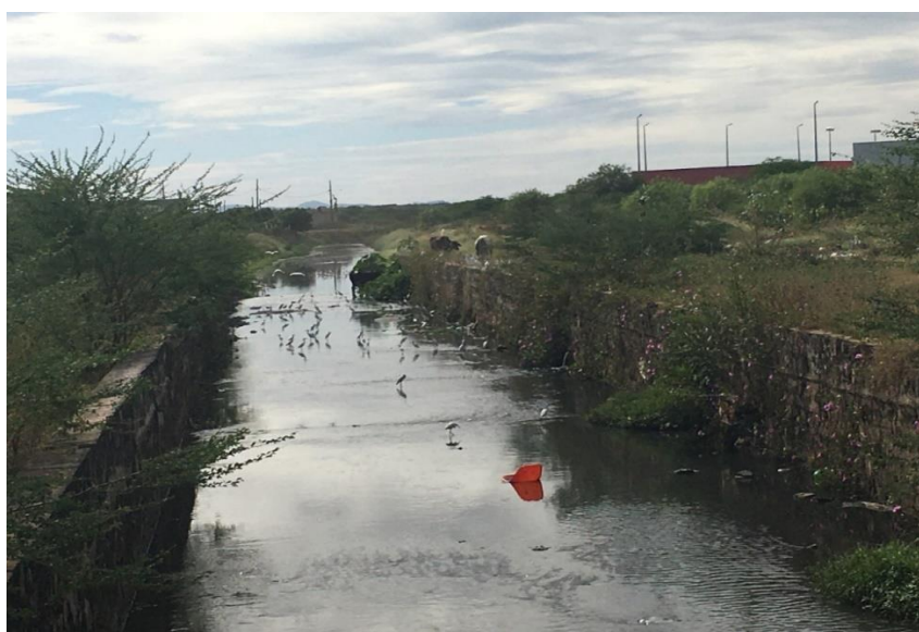
Figura 8: Foto sobre a ponte 15 do Canal do estreito Sousa – PB Fonte: Dados da Pesquisa, (2022)
