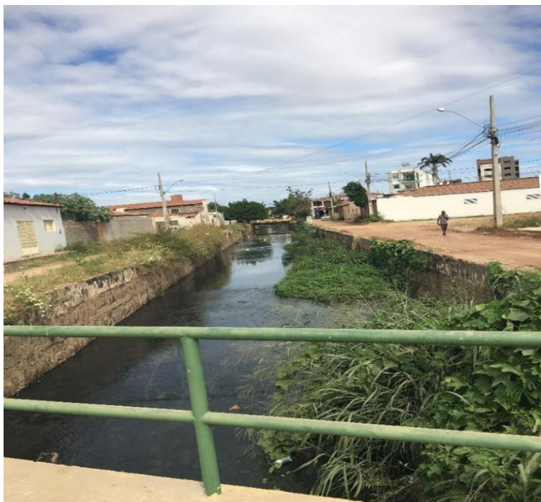
Figura 7: Foto sobre a ponte 13 do Canal do estreito Sousa – PB Fonte: Dados da Pesquisa, (2022)
