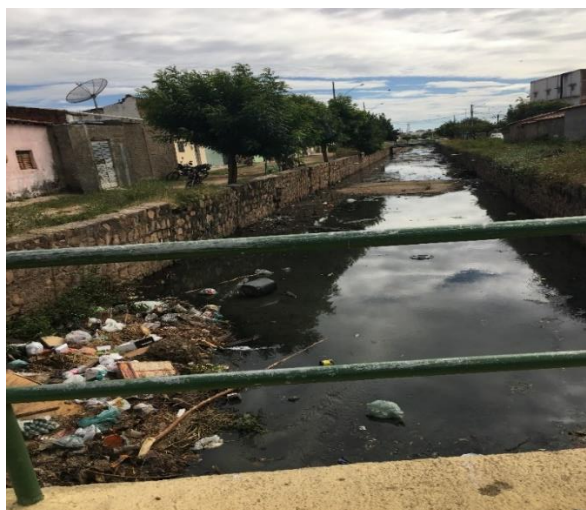
Figura 5: Foto sobre a ponte 2 do Canal do estreito Sousa-PB Fonte: Dados da Pesquisa, 2022
