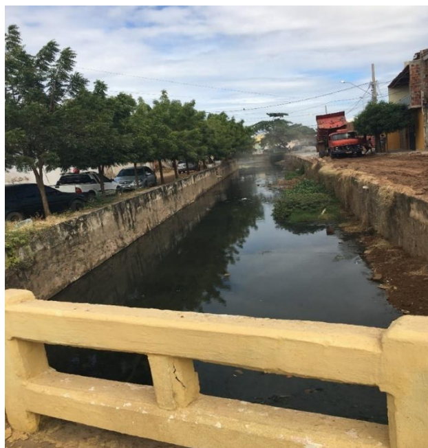
Figura 6: Foto sobre a ponte 12 do Canal do estreito Sousa – PB Fonte: Dados da Pesquisa, (2022)
