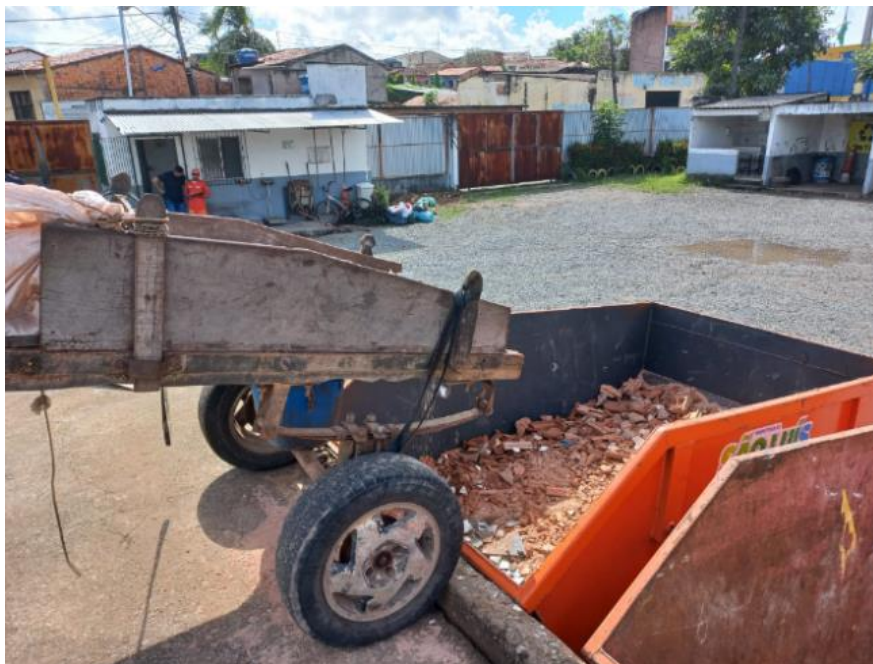
Figura 3 – Acondicionamento do RCC
