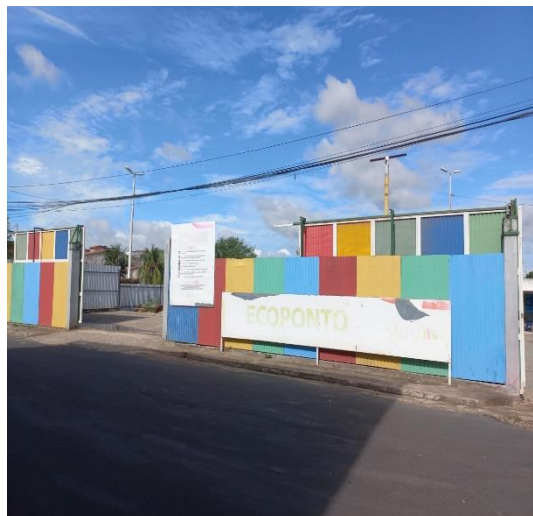
Figura 1 – Fachada do Ecoponto Residencial Primavera
