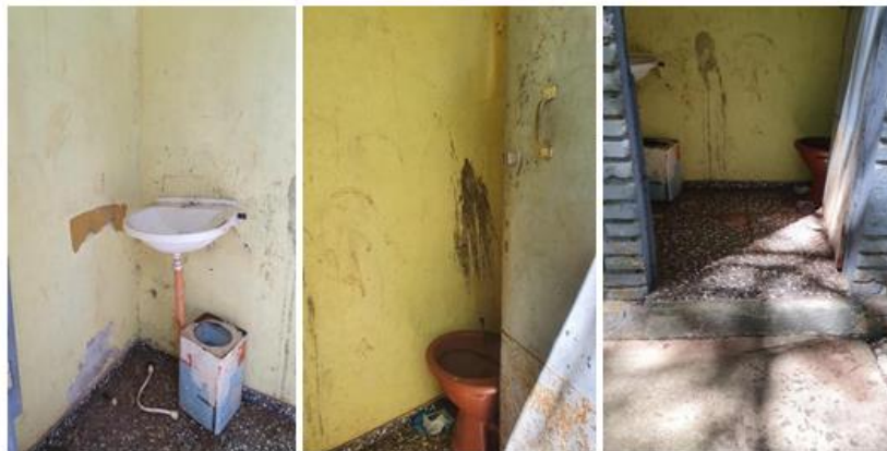
Figura 6: Sanitários da Praça do Bairro Modelo
