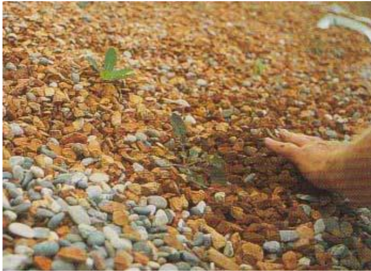
Figura 6 – Brown roof com substrato composto de seixo rolado e fragmentos de tijolo e telha. Fonte: Dunnnett e Kingsbury (2008)
