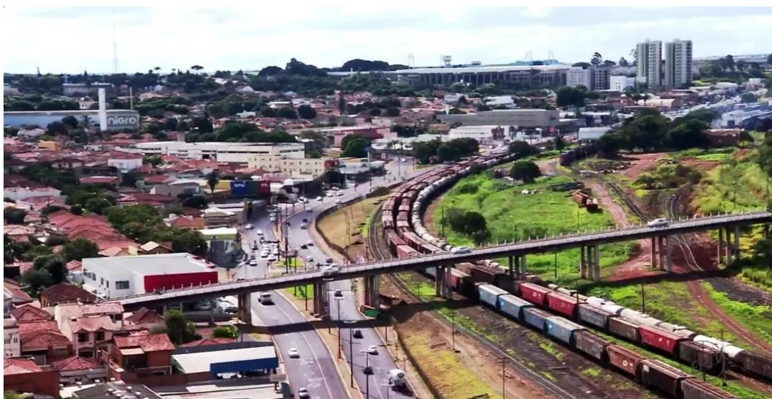
Figura 8 - Vista de uns dos trechos da via expressa Araraquara. Fonte: (G1, 2023)
