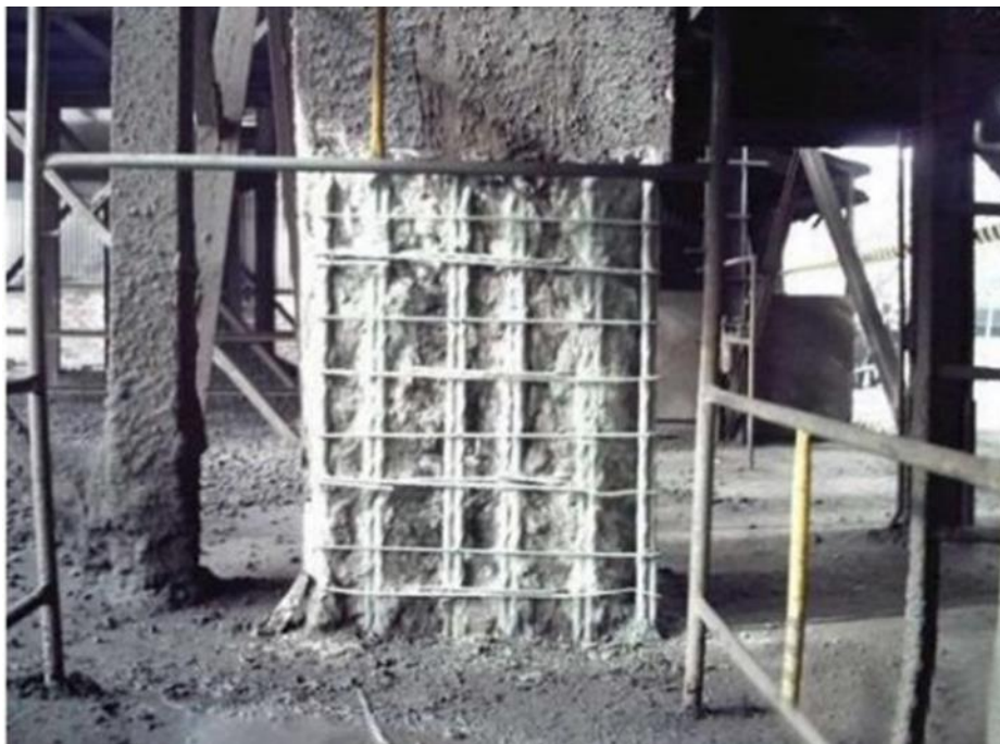
Figura 1 - Reparo de pilar com argamassa polimérica Fonte: (SANTOS,2017) p. 54
