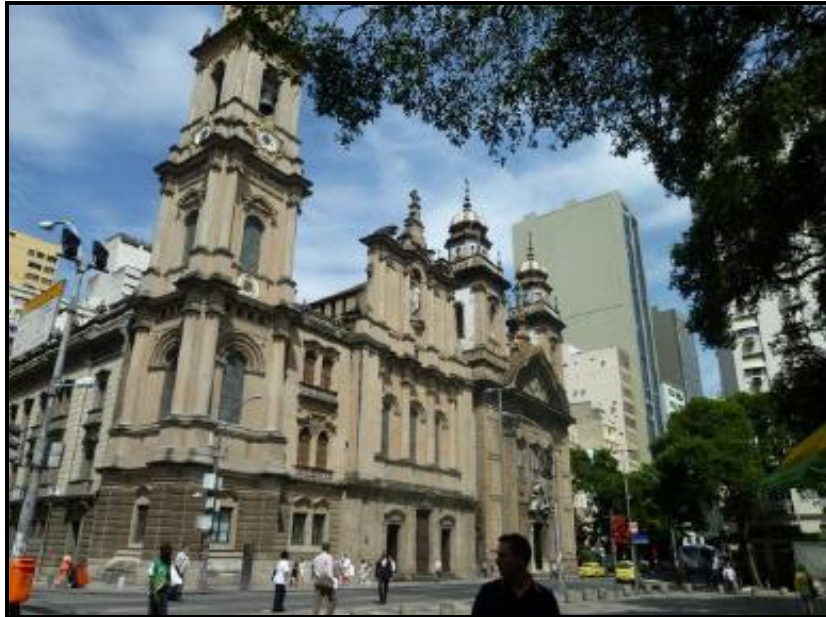
Figura 5. Entorno do Antigo Convento do Carmo, Igreja de Nossa Senhora do Monte do Carmo e da Ordem Terceira do Carmo. Pça XV de Novembro, Rio de Janeiro/RJ. Dezembro/2013 (Fonte: autor)
