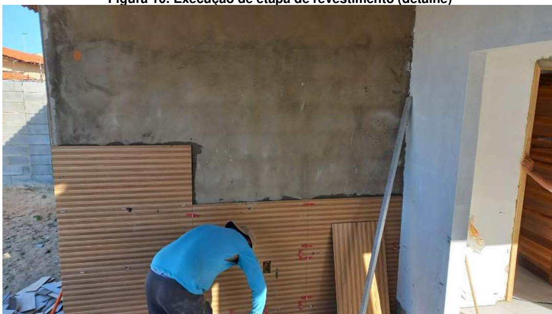
Figura 10. Execução de etapa de revestimento (detalhe)
