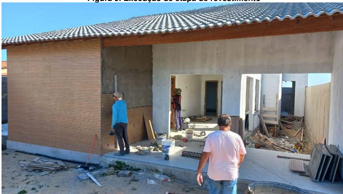
Figura 9. Execução de etapa de revestimento
