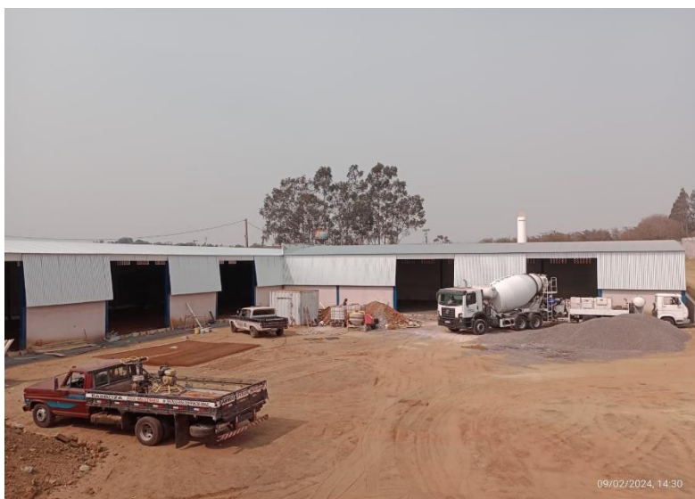
Figura 5 - Situação externa após reforma da estrutura metálica
