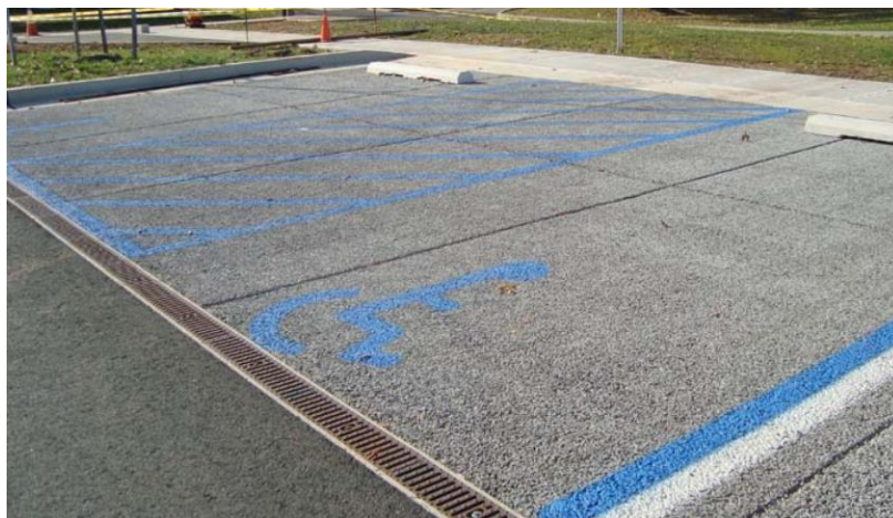
Figura 7. Pavimentação permeável com revestimento de concreto poroso Fonte: Marchioni e Silva, 2010.
