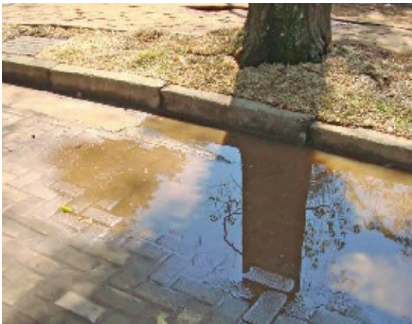
Figura 17. Colmatação das juntas da pavimentação intertravado permeável Fonte: Marchioni e Silva, 2010.
