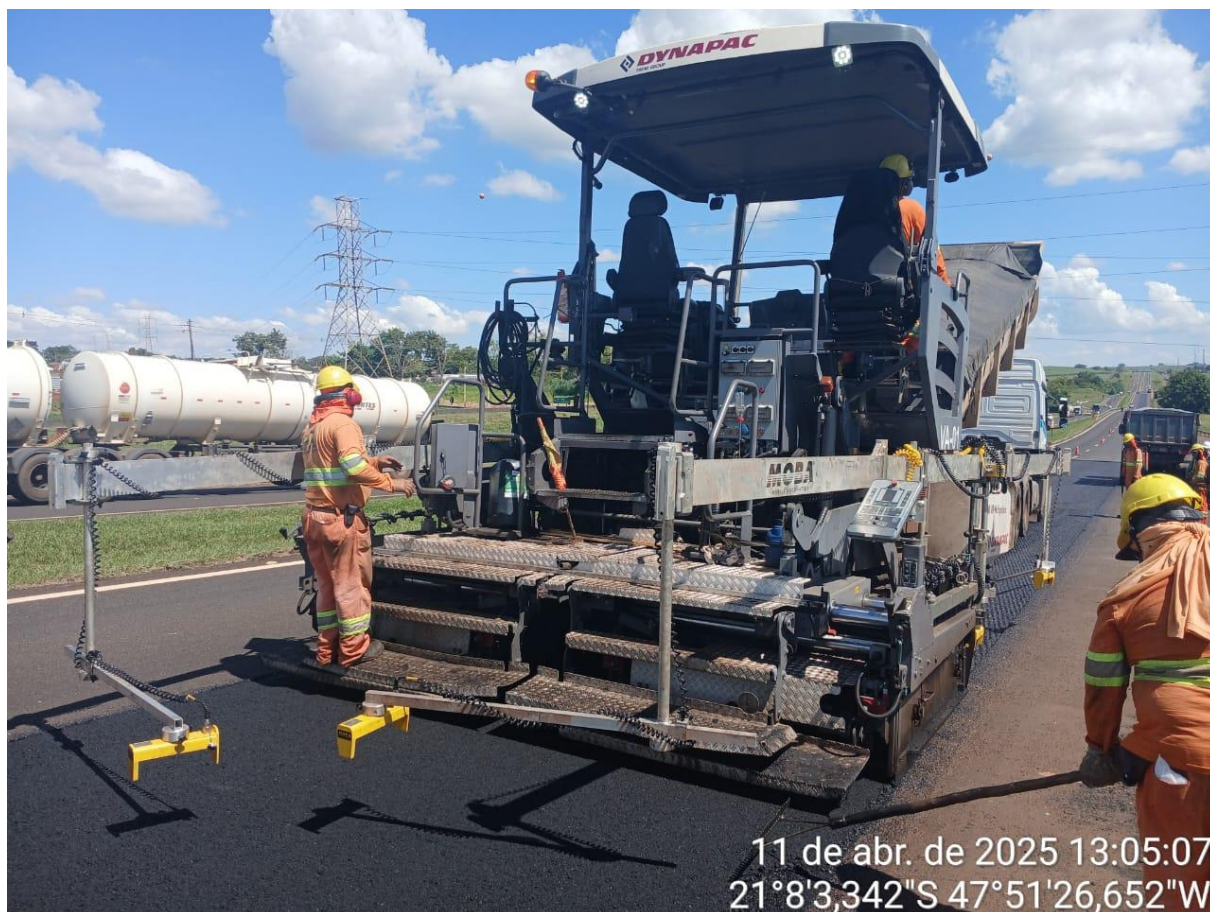
Figura 2. Aplicação do asfalto-borracha em campo
