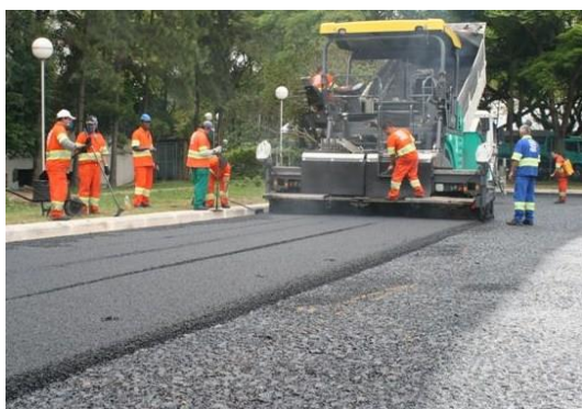
Figura 7. Execução de pavimento permeável
