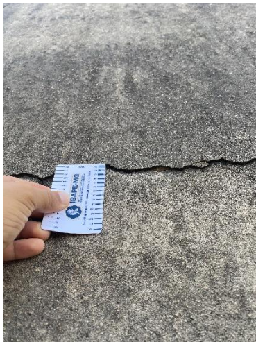
Figura 9. Rachadura de 5 milímetros, Casa C10
