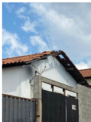
Figura 13. Telhado Soltando, Casa C7
