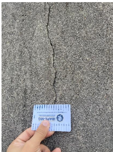
Figura 8. Trinca de 2 milímetros, Casa C10
