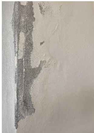
Figura 7. Pintura Estragada pela Umidade, Casa A5
