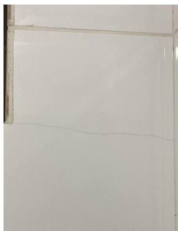
Figura 5. Cerâmica Trincada, Casa C16
