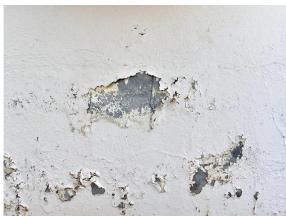
Figura 3. Infiltração em paredes e revestimentos
