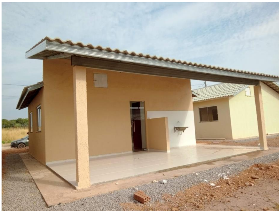
Figura 2. Edificação com sistema de parede de concreto
