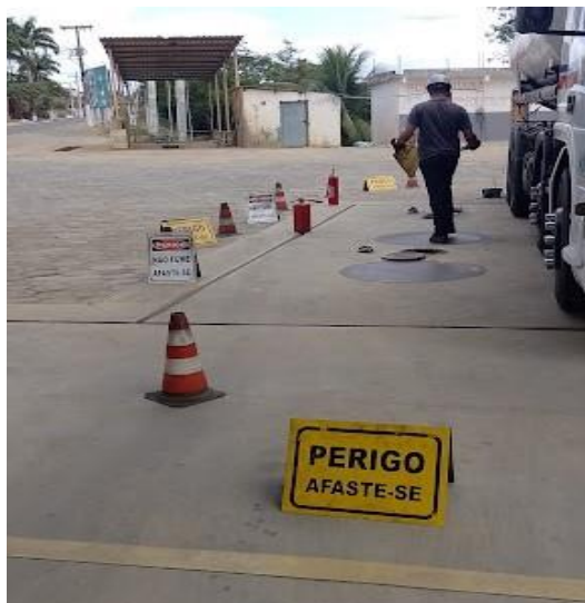
Sinalização da área para descarregamento de combustíveis
