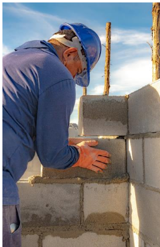
Figura 2. Etapa de levante da alvenaria estrutural com equipe local
