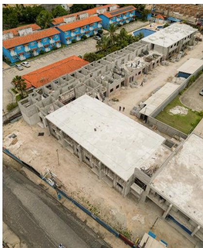
Figura 1. Vista geral do empreendimento em construção
