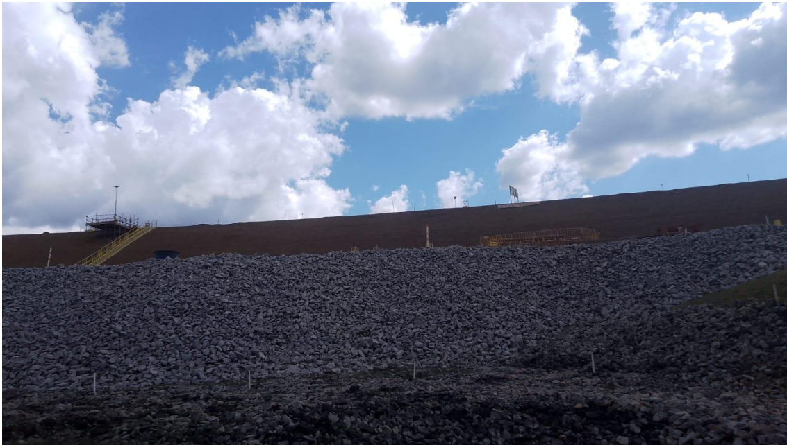
Figura 1. Barragem de Rejeitos
