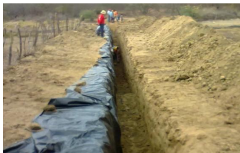
Figura 7. Barragem Subterrânea em Queimadas-PB
